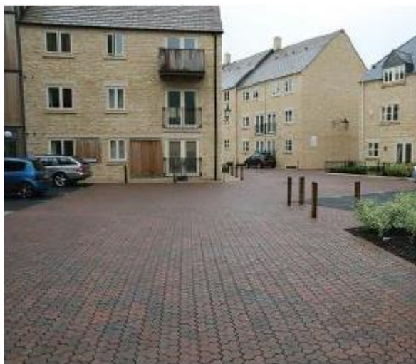
Figura 7. Sinistra: esempio pavimentazione permeabile (Woods Ballard et al. 2015. "The Suds Manual"). Destra: Tipologico pavimentazione permeabile
